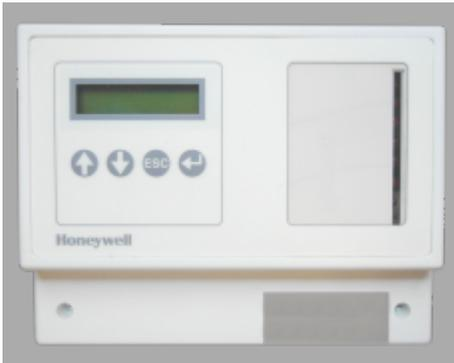
Менеджер каскада котлов типа AX 5200 SQ дает возможность на соединение и управление каскадом от 2 до 5 котлов.
